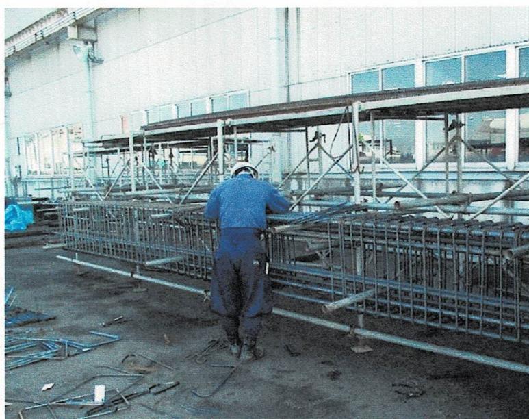
工場にての組立状況
